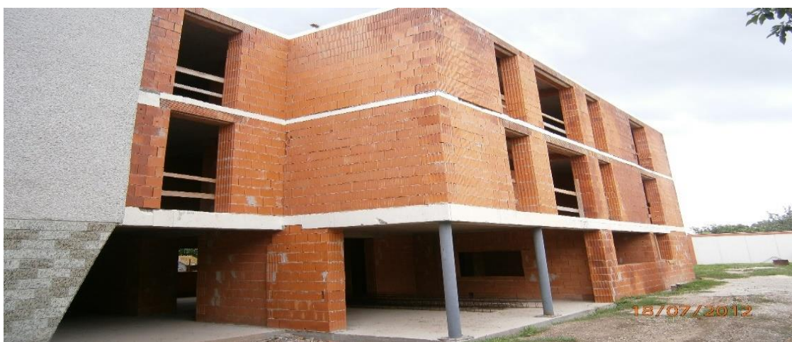
Obrázok 1 Prístavba Domova dôchodcov TEREZA n.o.
