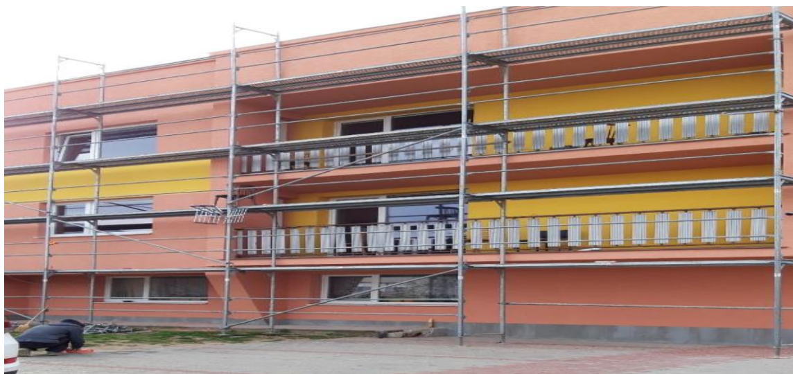
Obrázok 3 Zateplenie starej časti budovy
