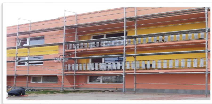
Obrázok 3 Zateplenie starej časti budovy
